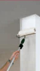
Rollen mit Airless-Technik: Das Beschichtungsmaterial wird durch die Airless-Anlage automatisch vom Gebinde in die Farbwalze gefördert. Bequemes und rationelles Arbeiten ohne Eimerschleppen und Eintauchen in das Gebinde.
