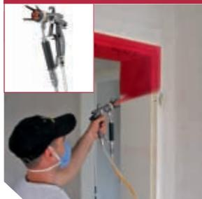
Die AirCoat-Pistole für ergiebige Lackierarbeiten auf der Baustelle. Leicht und mit perfekter Ergonomie (mit ACF 3000-Düse).
