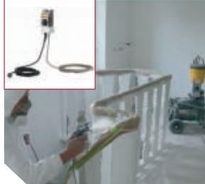
Durch die Erwärmung im Heizschlauch haben die Beschichtungsmaterialien immer die ideale Verarbeitungstemperatur.
